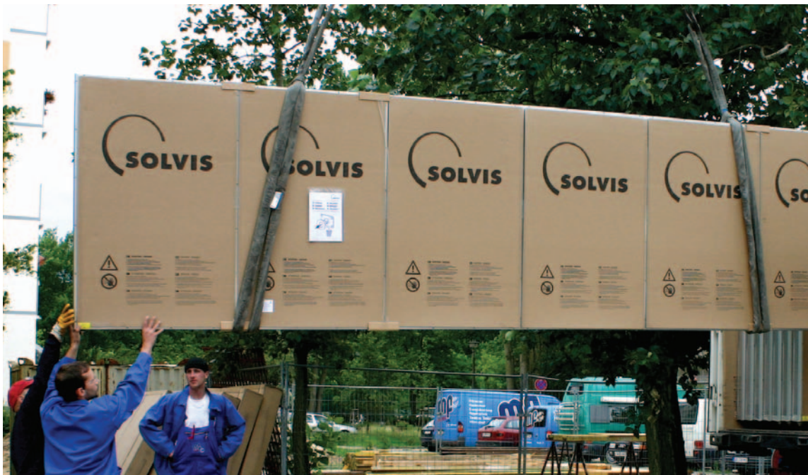
Großflächenkollektoren von bis zu 8,4 m 2 helfen die Anzahl der Kollektorverbindungen untereinander zu reduzieren
